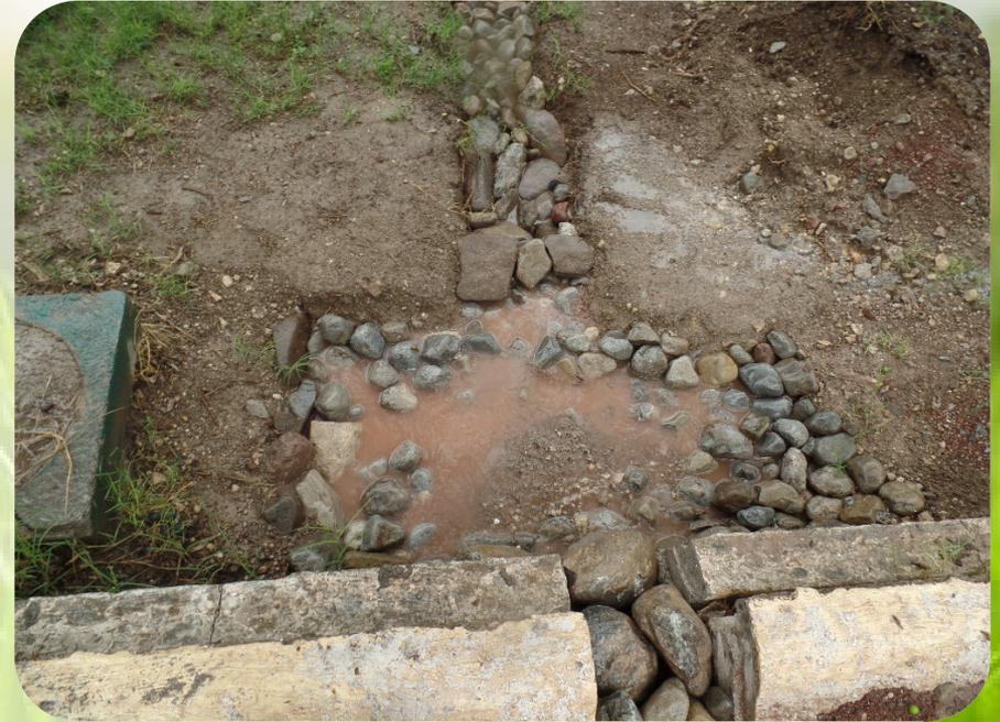
Cajas de agua con mayor profundidad que reciben el agua y conforme se llenan la van distribuyendo al terreno que la retiene mediante bordes.
