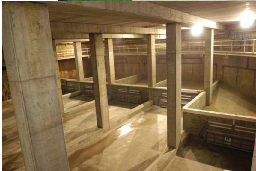
Estanque de retención subterráneo, Barcelona, España
