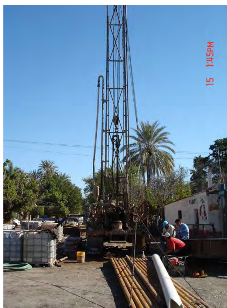
El sistema de infiltración: pozos profundos con tubo perforado en las áreas tributarias de cada desembocadura vial
