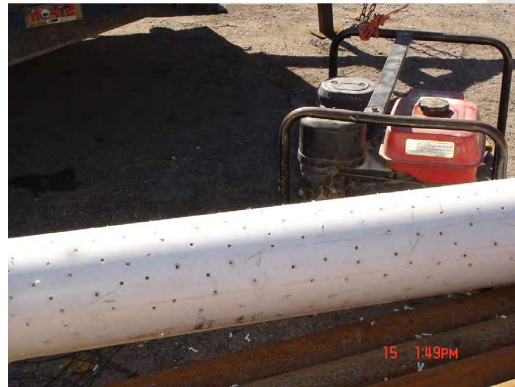
El sistema de infiltración: pozos profundos con tubo perforado en las áreas tributarias de cada desembocadura vial
