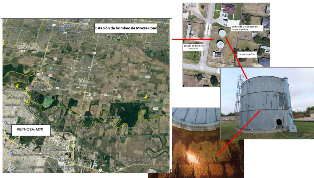
Figura 3 ESTACIÓN DE BOMBEO DE MOORE RD
